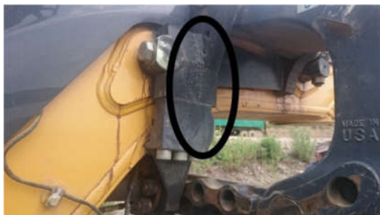
Рис.8 - Заваренная трещина на кронштейне крепления гидроцилиндров автогрейдера, возникшая от неучтенных реальных нагрузок
